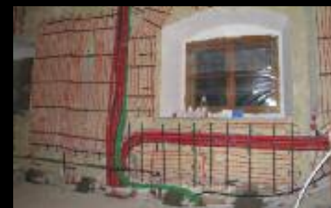
Die Bilder aus der Umbauphase dokumentieren den Umfang der Arbeiten. Die Wände wurden mit einer modernen Wandheizung versehen, bevor sie neu verputzt wurden. Neue Leitungen wurden verlegt und das historische Fenster erneuert. Zudem fanden die Tiefenbohrungen für die Wärmepumpe statt.
