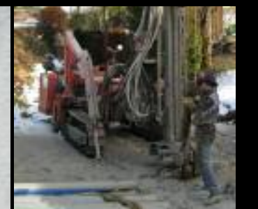
Die Bilder aus der Umbauphase dokumentieren den Umfang der Arbeiten. Die Wände wurden mit einer modernen Wandheizung versehen, bevor sie neu verputzt wurden. Neue Leitungen wurden verlegt und das historische Fenster erneuert. Zudem fanden die Tiefenbohrungen für die Wärmepumpe statt.
