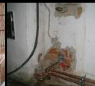
Die Bilder aus der Umbauphase dokumentieren den Umfang der Arbeiten. Die Wände wurden mit einer modernen Wandheizung versehen, bevor sie neu verputzt wurden. Neue Leitungen wurden verlegt und das historische Fenster erneuert. Zudem fanden die Tiefenbohrungen für die Wärmepumpe statt.
