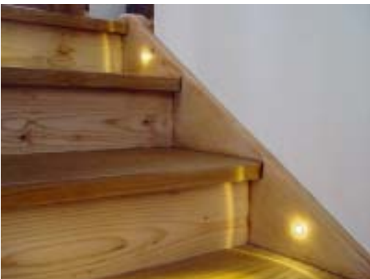
Sicherheit im Aufstieg: In die Treppenwange eingelassene LED-Spots beleuchten den Treppenlauf zum oberen Stockwerk
